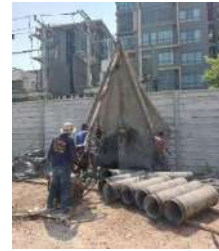
ภาพที่ 15 งานถอนปลอกเหล็ก (Casing)
