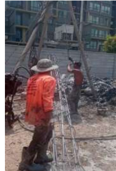
ภาพที่ 13 งานลงเหล็กเสริมคอนกรีต
