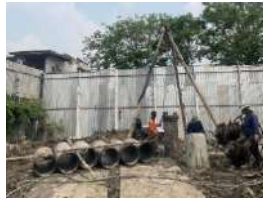
ภาพที่ 10 งานต่อปลอกเหล็ก (Casing)
