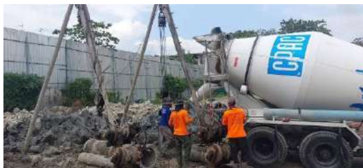
ภาพที่ 14 งานเทคอนกรีต
